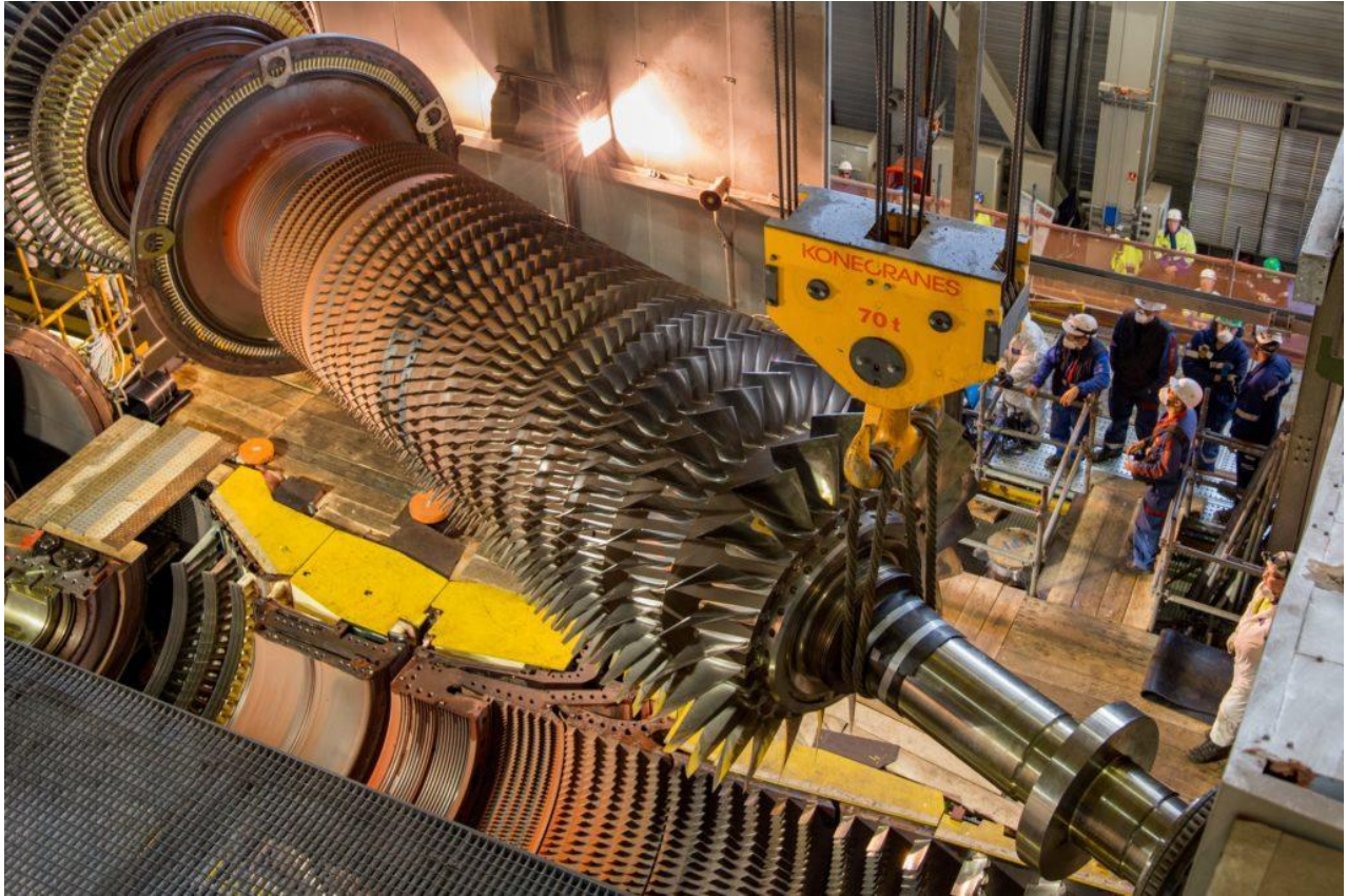
Figure 9 : Turbine à Gaz – Inspection C
